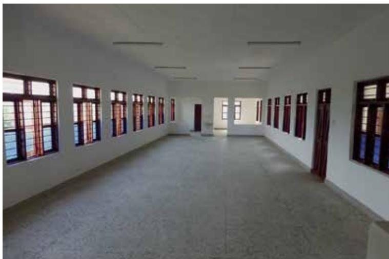
Neubau der Wochenbettstation.
